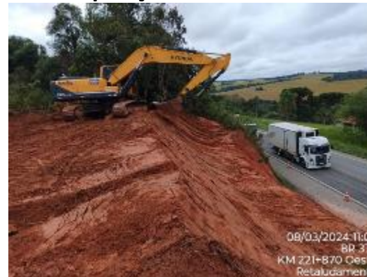
Recomposição de taludes
