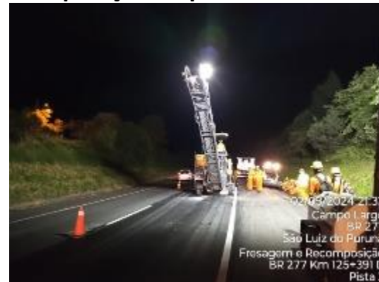
Recuperação de pavimento
